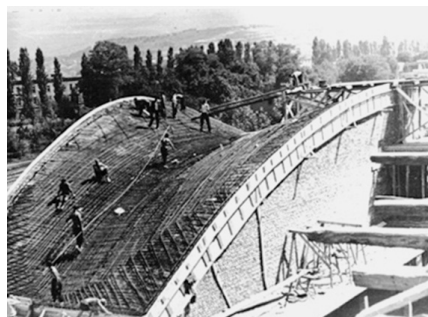
SLIKA 8. Gradnja Velike predavaonice za kemiju, krovna konstrukcija
